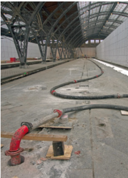
BILD 5: Pumpleitungen für Flüssigboden im Untergeschoss des Hauptbahnhofes
