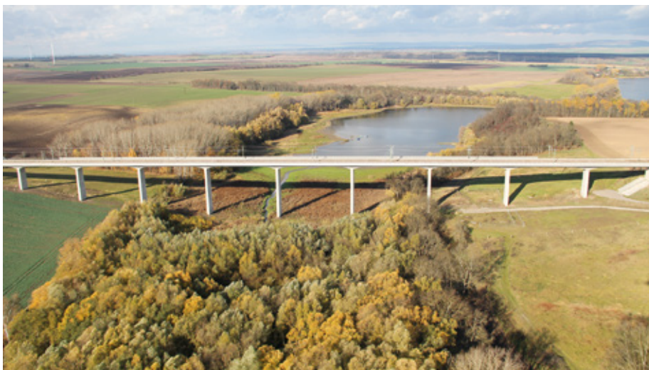
BILD 13: Scherkonde-Talbrücke (Luftbild) fertig gestellt
