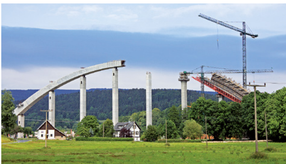
BILD 9: Grümpen-Talbrücke (Bogenherstellung auf temporären Hilfspfeilern)
