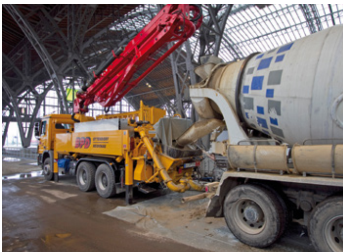
BILD 2: Einsatz Betonpumpe für Einbau Flüssigboden
