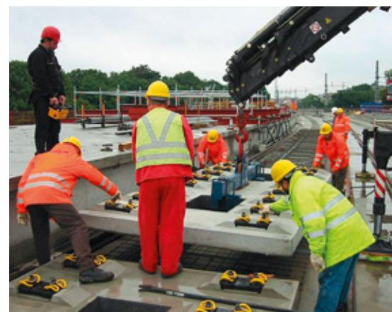
BILD 5: Verlegung einer Gleistragplatte des Systems ÖBB-Porr (Foto: Porr)
