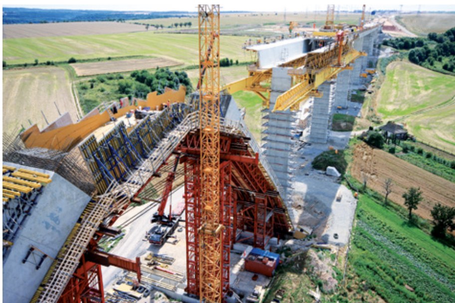
BILD 19: Unstrut-Talbrücke, A-Bock im Bau
