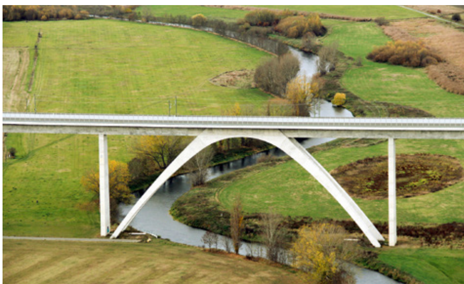
BILD 20: Unstrut-Talbrücke, A-Bock fertig gestellt
