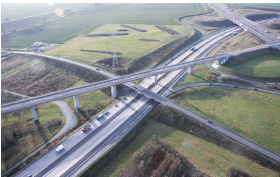
BILD 11: Gera-Talbrücke Ichttershausen (Querung der A 71)
