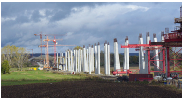
BILD 15: Gänsebachtalbrücke 2010 im Bau, neuer Entwurf
