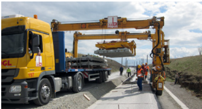
BILD 4: Der Portalkran der Firma Max Bögl zur Verlegung der Gleis-tragplatten (Aufnahme der BÜ)
