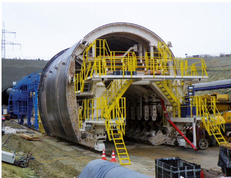
BILD 9: Bibratunnel – Schalwagen für die Innenschale
