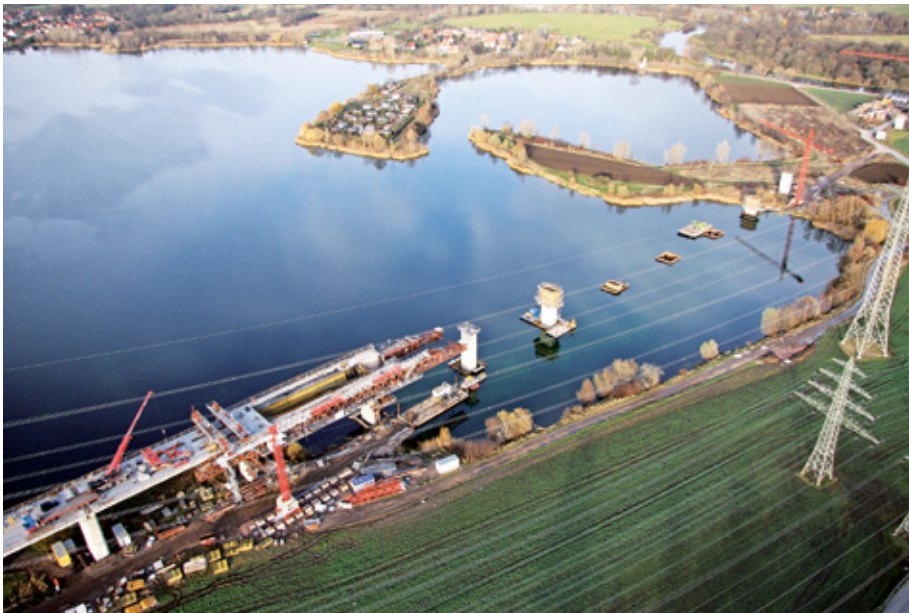
BILD 24: Saale-Elster-Talbrücke, Baustelle im Rattmannsdorfer Teich
