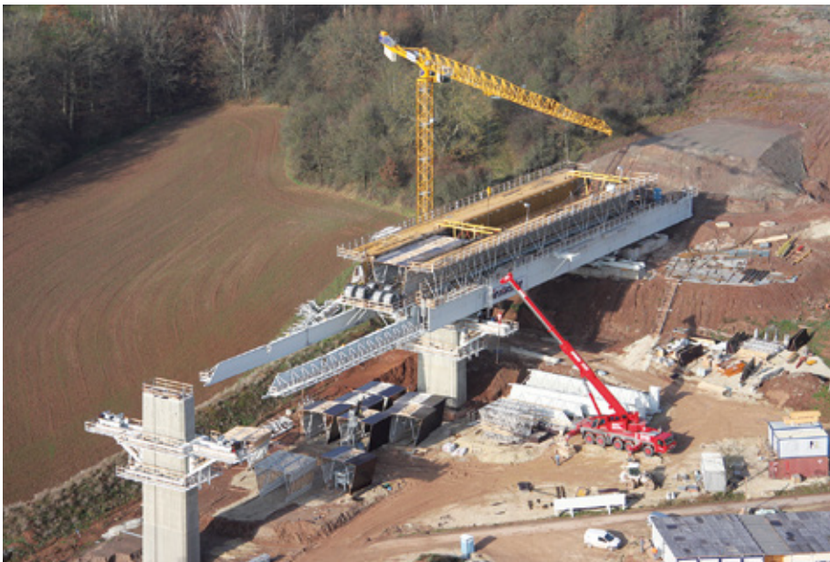
BILD 5: Füllbach-Talbrücke (Überbauherstellung mit Vorschubrüstung)
