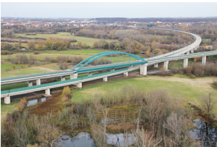
BILD 25: Saale-Elster-Talbrücke, Abzweig der Strecke nach Halle (Mai 2012) (Foto: Frank Kniestedt, DB)
