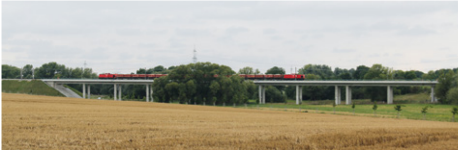
BILD 23: Stöbnitz-Talbrücke, Belastungstest
