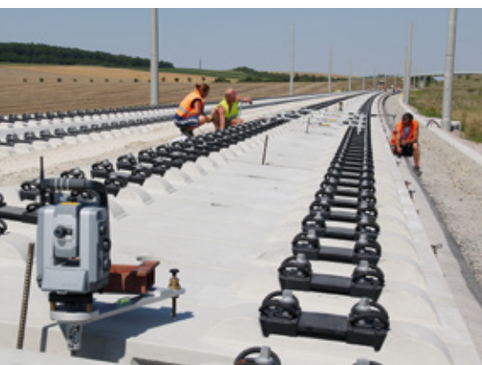
BILD 1: Vermessen der Fahrbahnplatten System Max Bögl im Nordabschnitt (Bildquelle: DB AG)
