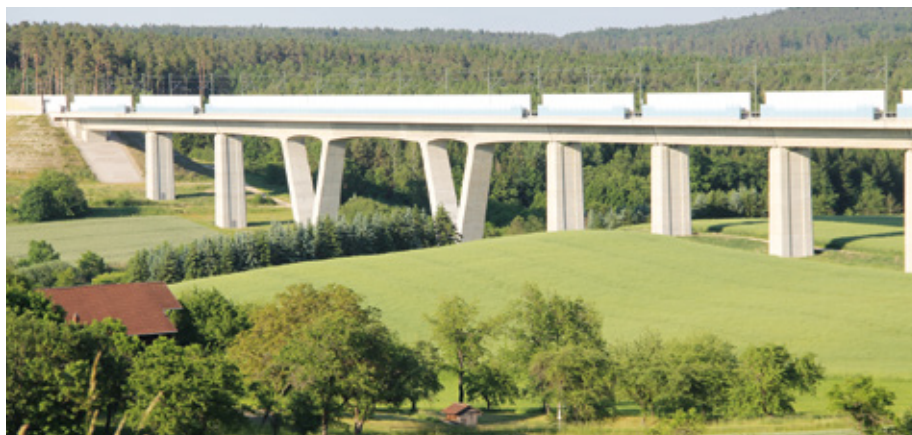
BILD 3: Talbrücke Weißenbrunn am Forst
