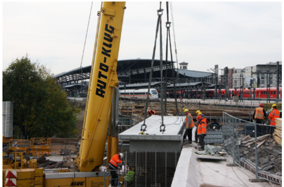
BILD 6: EÜ Schmidstedter Knoten beim Umbau
