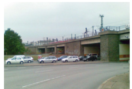
BILD 5: Foto vorhandener Zustand vor Umbau
