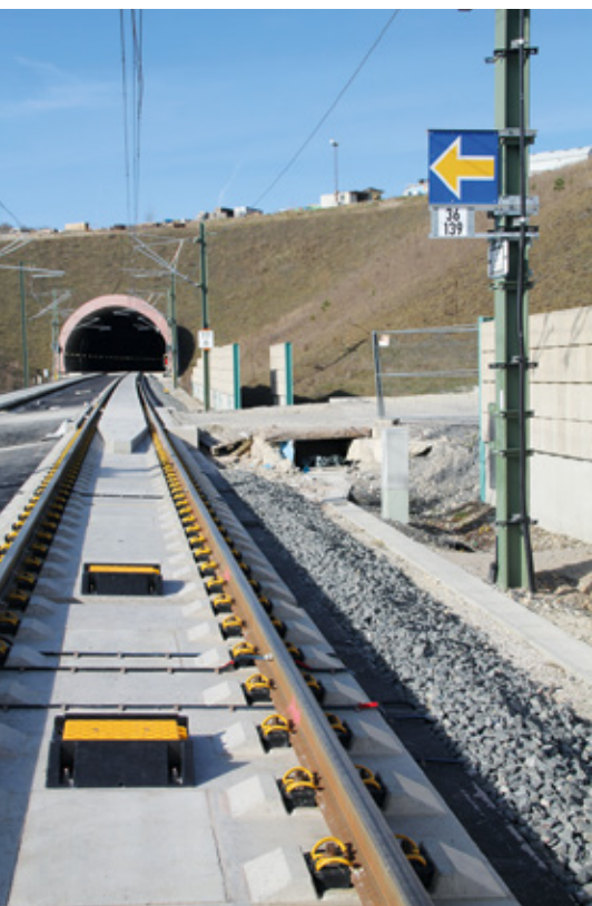
BILD 1: VDE 8 - Sicherungstechnik - Balisen für ETCS Level 2
