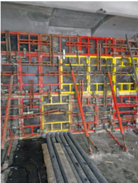
BILD 4: Abschaltung im Untergeschoss Hauptbahnhof
