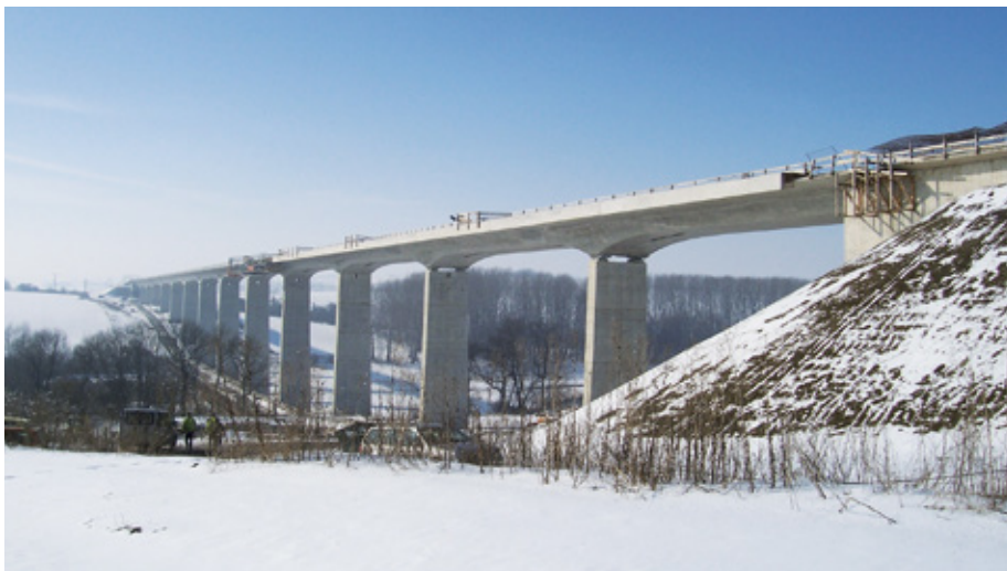
BILD 14: Scherkonde-Talbrücke; vorne rechts zwei Pfeiler mit Lagern
