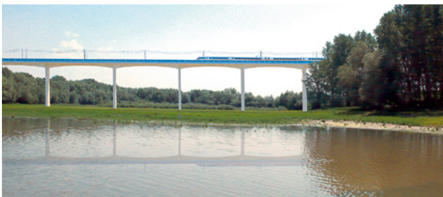
BILD 2: NBS Erfurt – Halle/Leipzig – Scherkonde-Talbrücke
