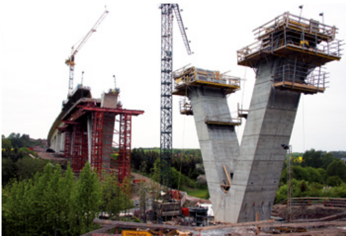
BILD 4: Talbrücke Weißenbrunn am Forst (Herstellung V-Stützen)
