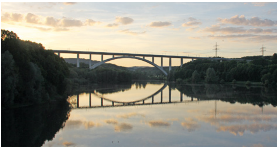
BILD 7: Talbrücke Froschgrundsee (Bogen mit 270 m Spannweite)
