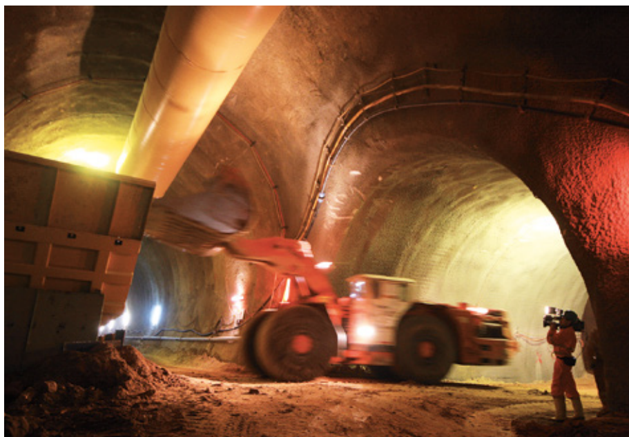
BILD 8: Bibratunnel – Querschlag im Bau
