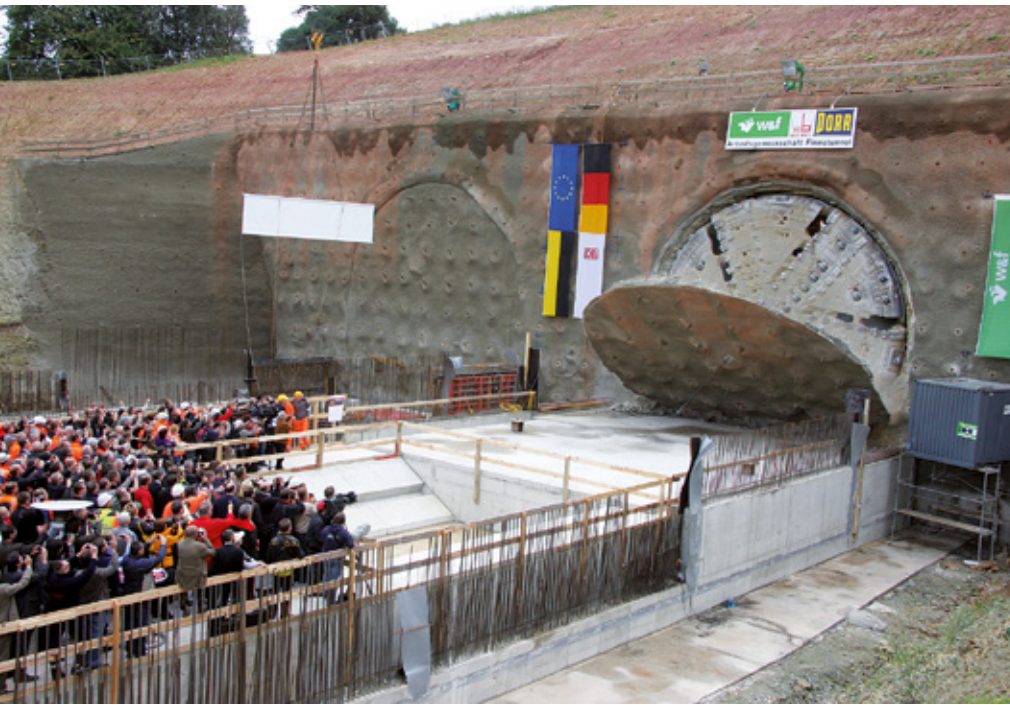
BILD 7: Finnetunnel – Durchschlag
