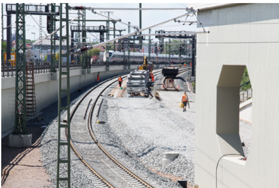
BILD 8: Kreuzungsbauwerk im Bau
