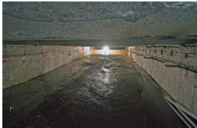
BILD 6: Einbau Flüssigboden
