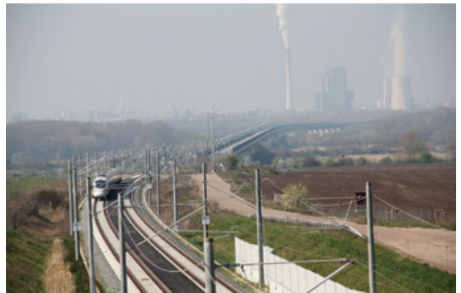
BILD 3: Die Saale-Elster-Talbrücke (Foto: DB AG/Hannes Frank)
