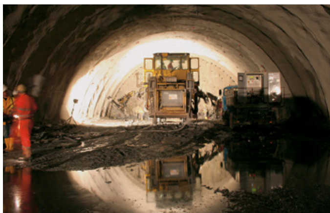
BILD 6: VDE 8.1 NBS Ebensfeld – Erfurt – Tunnel Bleßberg – Frühjahr 2007
