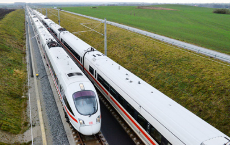
BILD 1: VDE 8.2 in Betrieb (Foto: Deutsche Bahn AG/ Oliver Lang)
