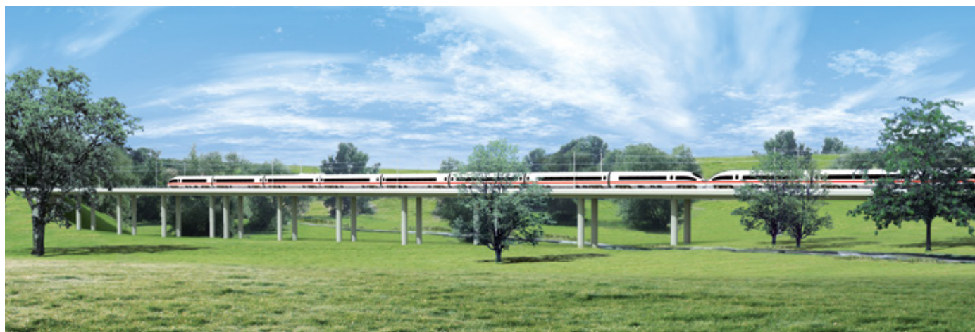
BILD 22: Stöbnitz-Talbrücke (geänderter Entwurf), Computeranimation
