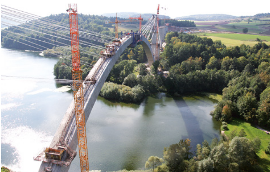
BILD 8: Talbrücke Froschgrundsee (Bogenherstellung mittels Pylonen)
