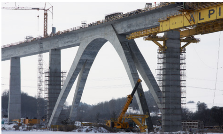
BILD 21: Unstrut-Talbrücke, Pfeiler mit Vorschubgerüst
