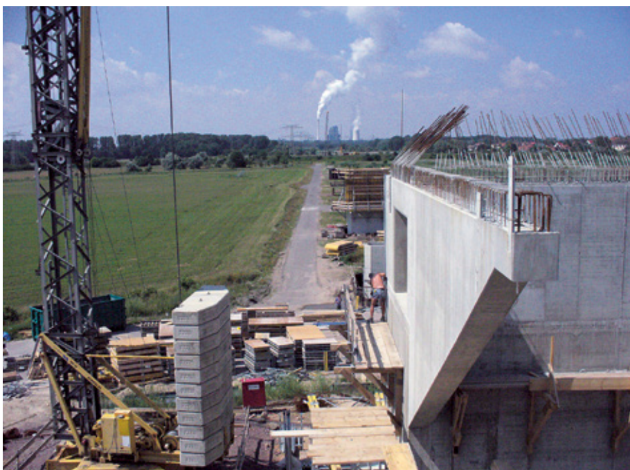
BILD 3: VDE 8.2 NBS Erfurt – Halle/Leipzig – Saale-Elster-Talbrücke im Bau
