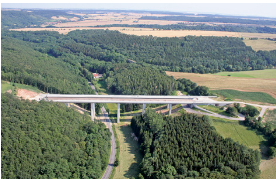
BILD 1: VDE 8.2 Erfurt – Halle/Leipzig – Talbrücke Saubachtal – Sommer 2007 (Alle Bilder: DB AG)
