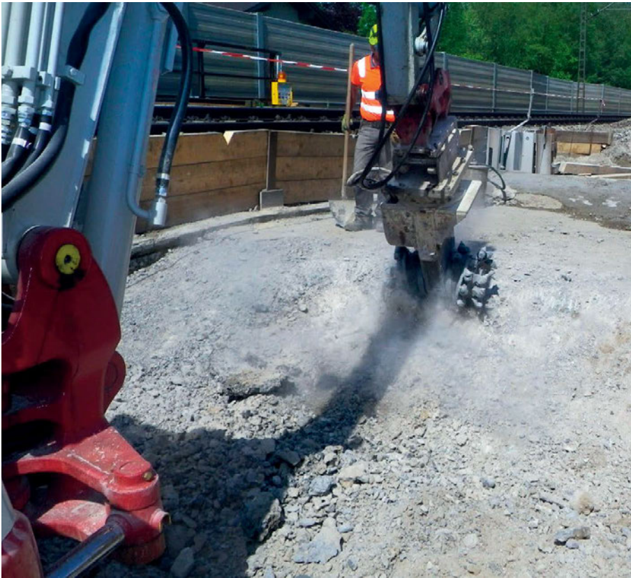
Abb. 4: Einsatz des Fräsens an einem Gewölberücken
