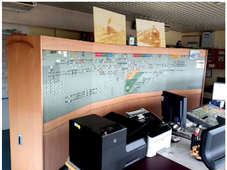
Meldetafel eines Spurplanstellwerks SpDrL60
