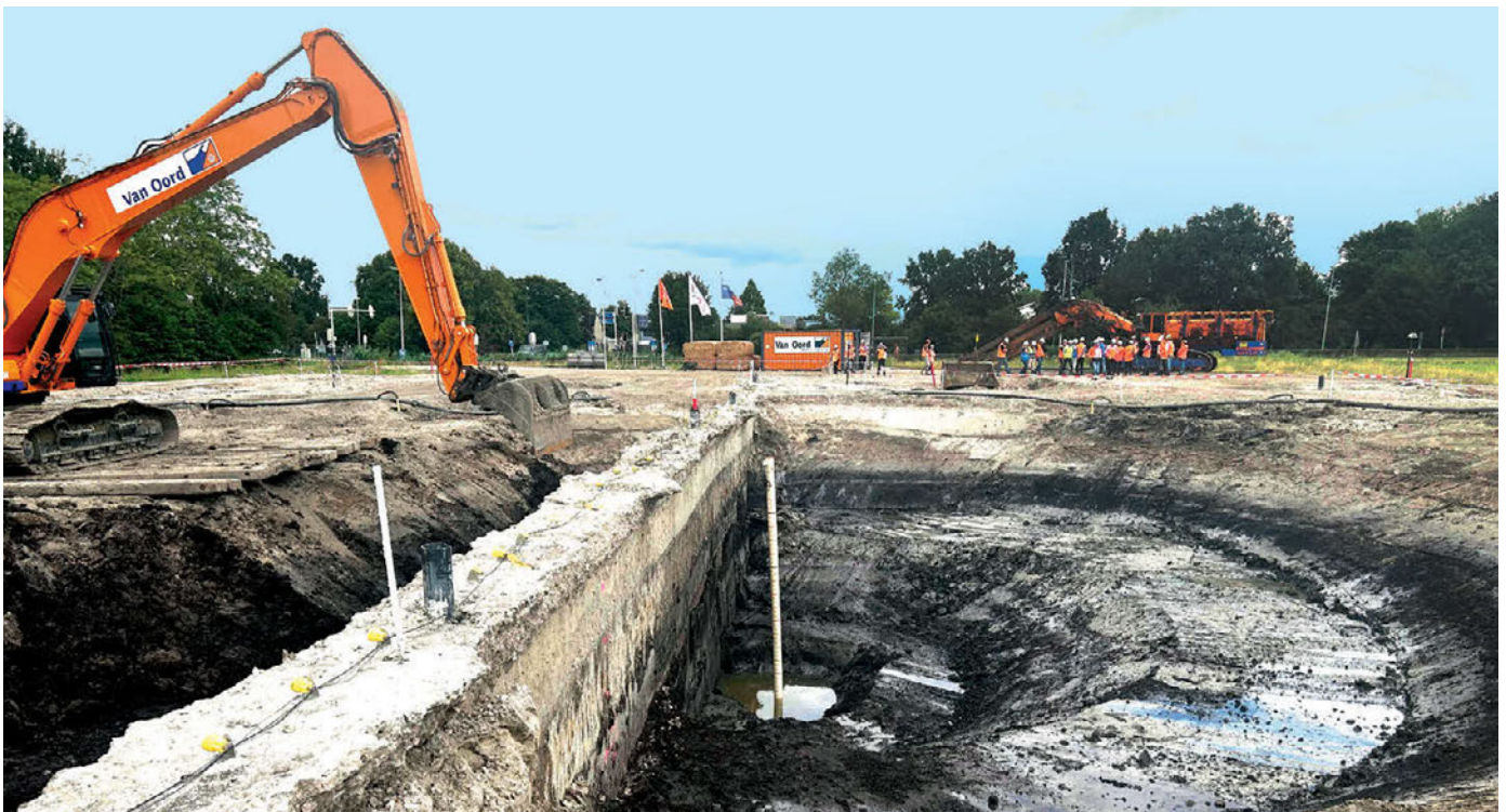
Abb. 3: Testgelände Niederlande – FMI-Wände bis 15 m Tiefe
