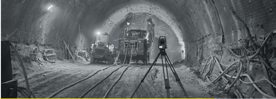
ÖBB, Semmering Basis- tunnel Baulos SBT 1.1 – geotechnische Messun- gen, 3D Verschiebungs- messungen, Kontrollmes- sungen, Geomonitoring
