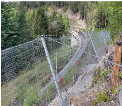
2: Schutznetz mit Fundierung nach RVS 08.22.02
