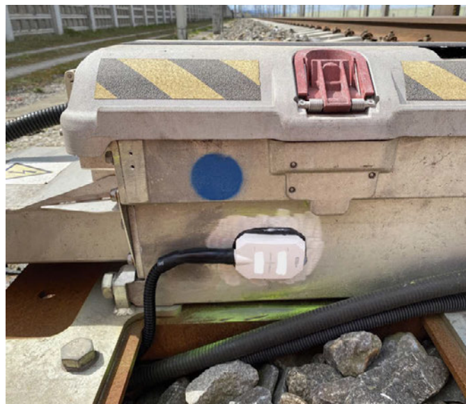
2: Eingebaute Messsensorik „zentrak IM“ der vaSIG am Weichenantrieb
