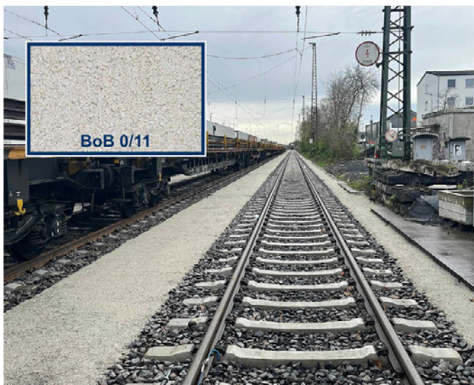
An der Strecke Mainz – Bischofsheim: Betriebswege ohne Bindemittel „BoB 0/11“ aus Henauer Quarzit Quelle: BVG
