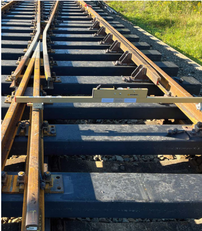
4+5: In Tschechien in Loucna nad Desnou wurde die neue Kunststoffschwelle STRAILway 30 für eine Weiche eingebaut. Die Installation der Schwellen für zukünftige Modernisierungen des Bahnnetzes verlief reibungslos
