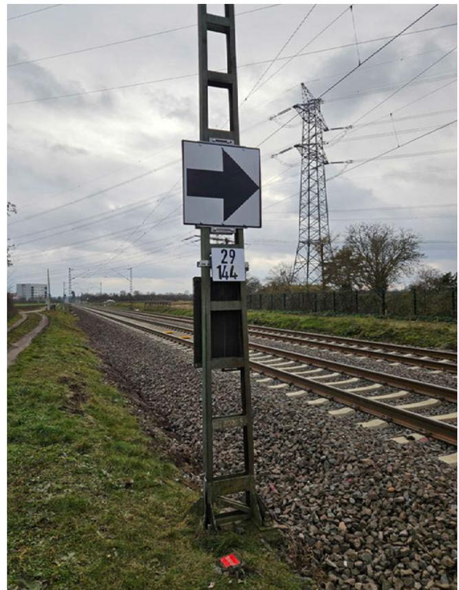
**Bild 4: Montage der ETCS-Blockkennzeichen**
