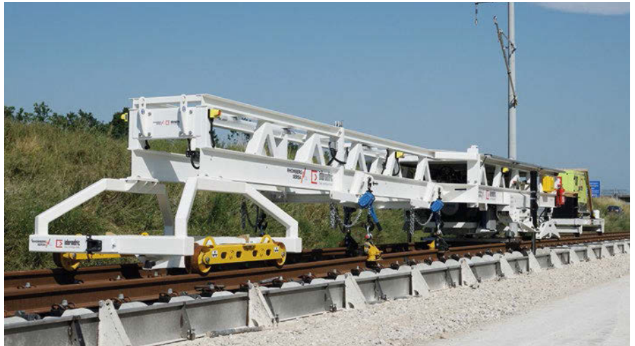
Abb. 14: Auf ein bis zwei Millimeter genau richtet das automatische Gleisrichtsystem RhoMat die neuen Gleise aus.
