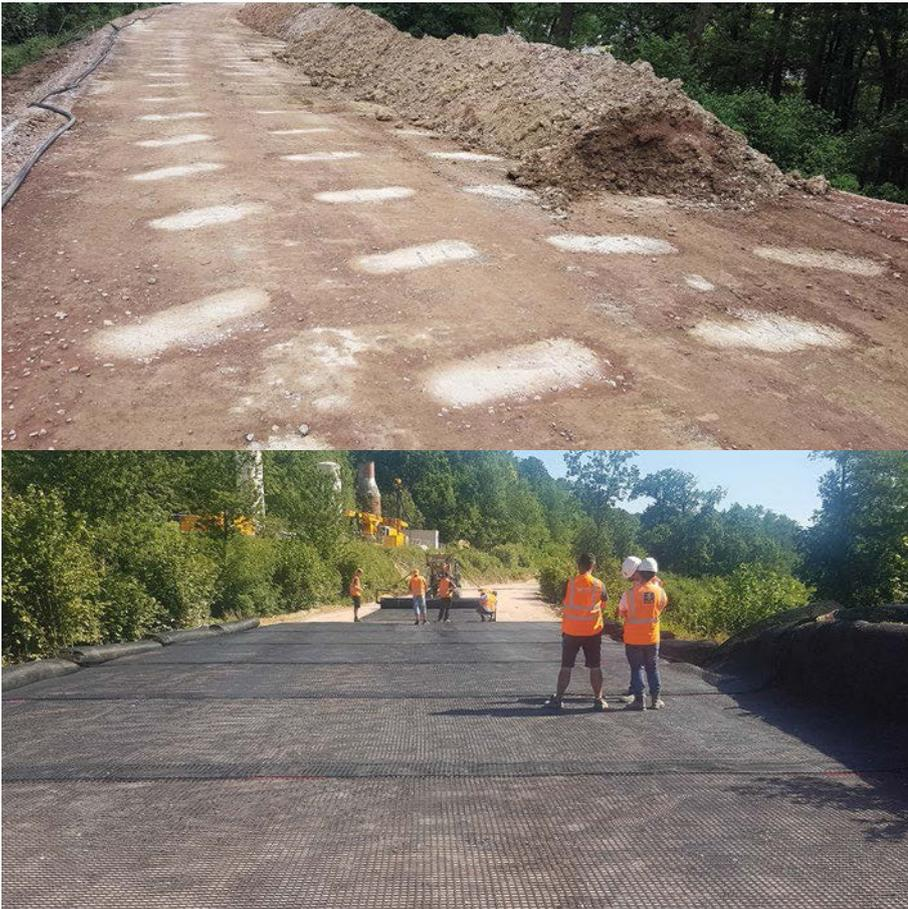
**Abb. 4:** Arbeitsebene mit eingebauten MIP-Elementen und ausgelegten Geogittern, vor dem Einbau der Lastverteilungsschicht
