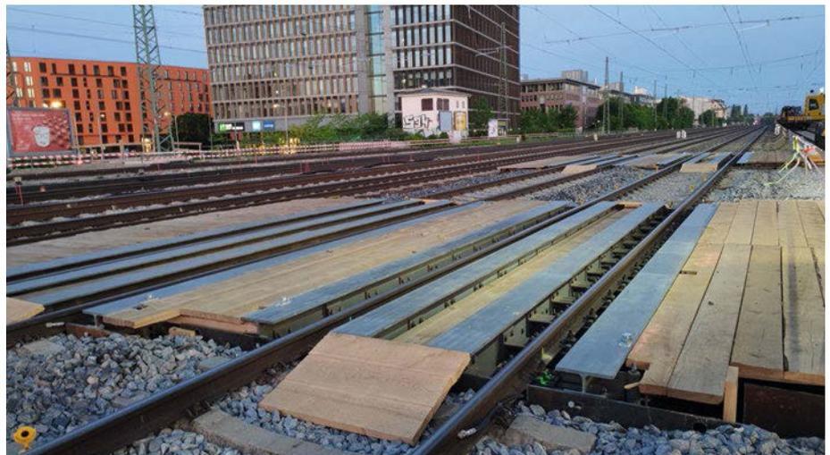
Abb. 6: Betriebsbereite Hilfsbrücke mit Monitoringprismen
