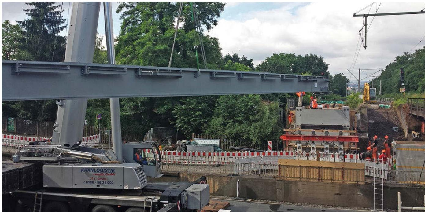
Abb. 1: Einbau einer ZH 31 an der Stauffenbergallee, Dresden
