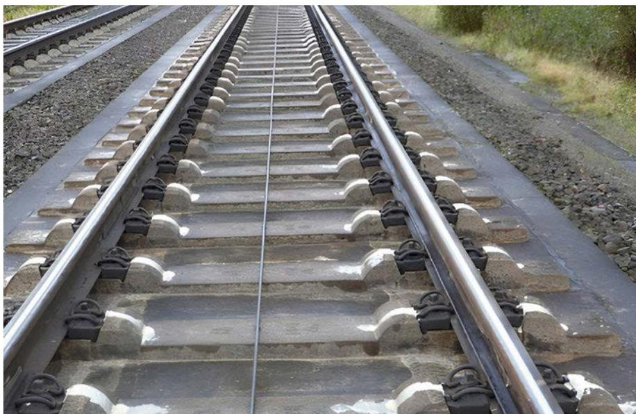
Abb. 8: Sanierte Schwellen in FF
