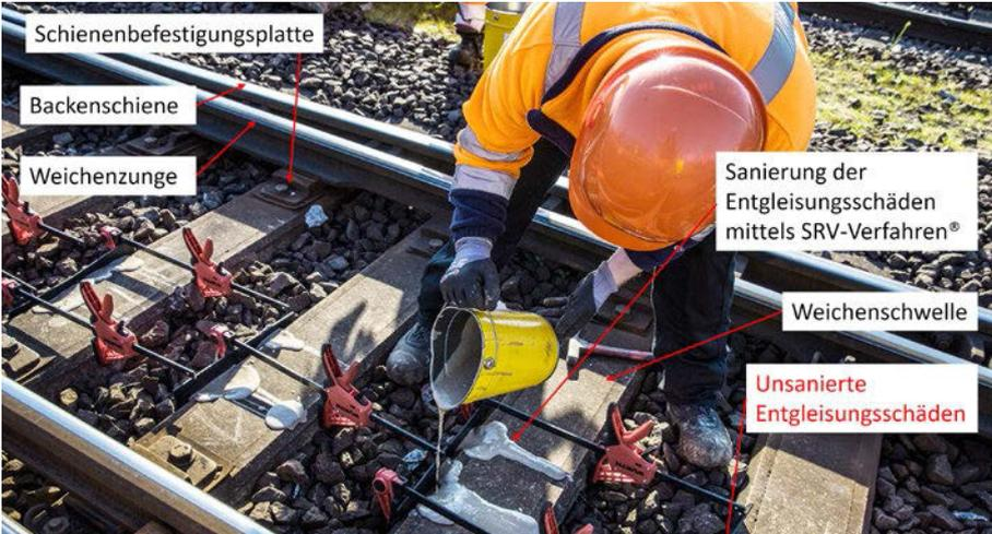
Abb. 6: Einsatz des SRV-Verfahrens zur Sanierung von Abplatzungen
