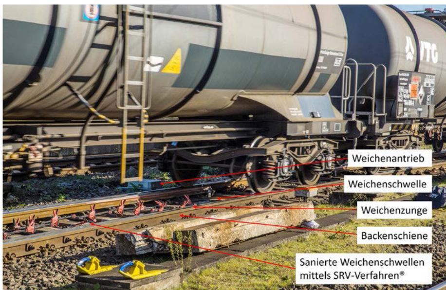
Abb. 7: Überfahrt eines Güterzuges unmittelbar nach dem Einsatz des SRV-Verfahrens
