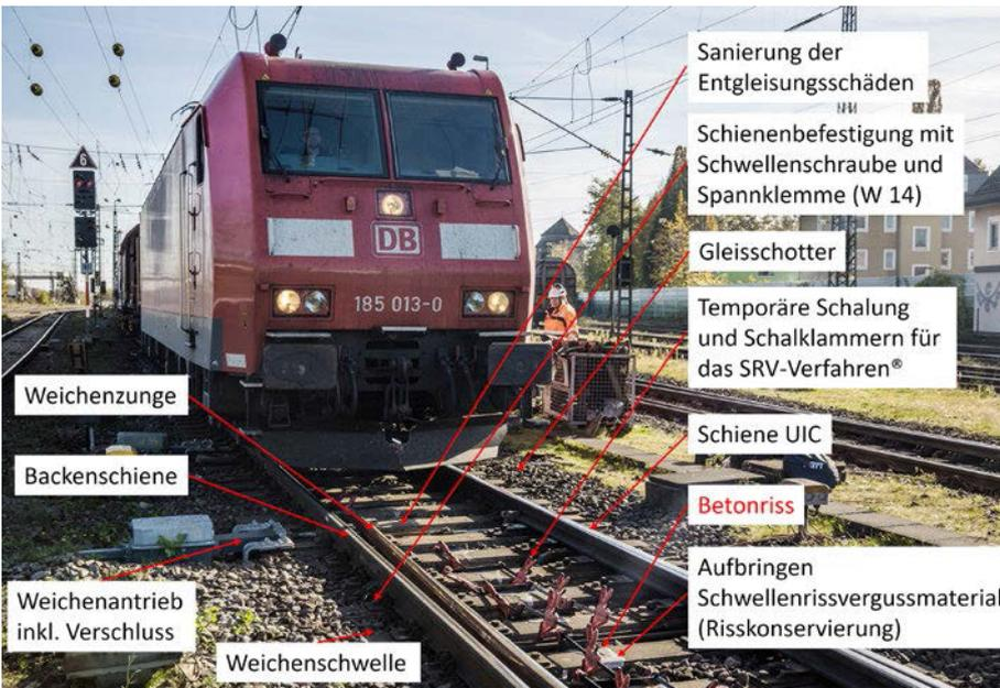
Abb. 4: Sanierungsarbeiten mit dem SRV-Verfahren unter dem „Rollenden Rad“
