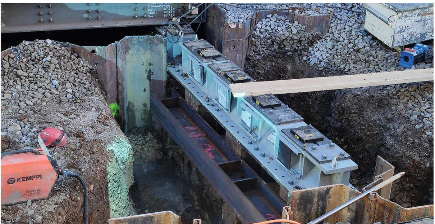
Abb. 5: Fertig eingerichteter Standardauflagerträger mit Elastomerlagern und Gurtung
