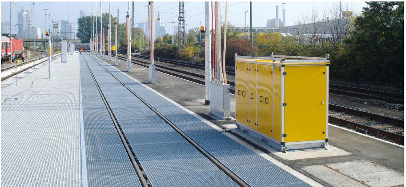
Die TUnit MP für die Abwasserentsorgung und Trinkwasserversorgung von Zügen als Mehrplatzlösung installiert
