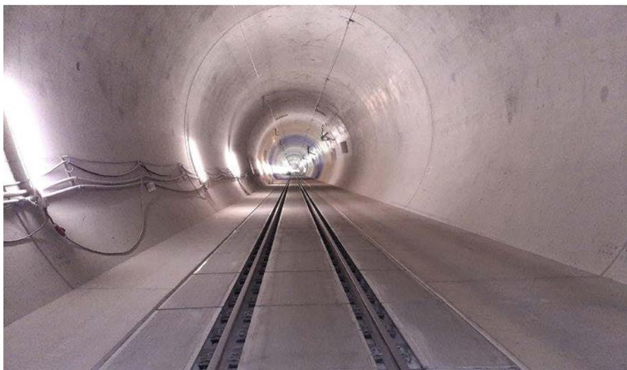
**Abb. 9:** Die fertigen Befahrbarkeitsplatten eben die Gleisfläche so ein, dass nicht schienengebundene Einsatzfahrzeuge problemlos vorwärtskommen.
