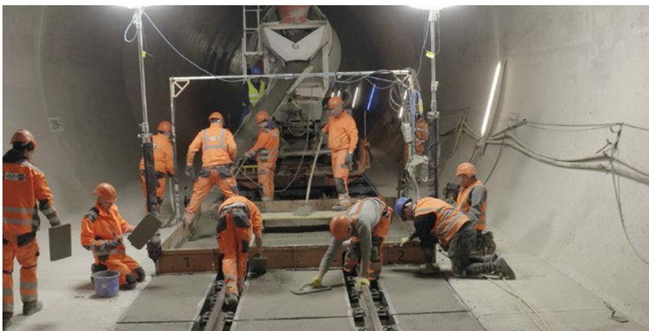
**Abb. 3:** Das Gleisbauteam beim Betonieren der Befahrbarkeitsplatten
