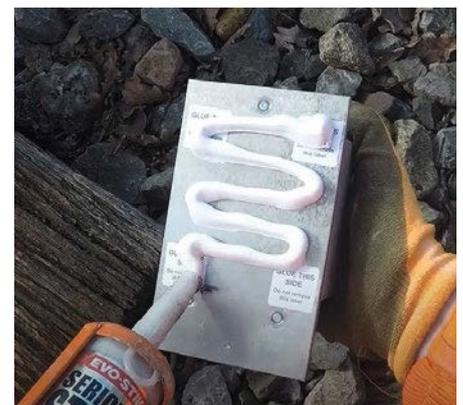
**Abb. 7:** Einfaches Verkleben spart Zeit im Gleisbereich.
