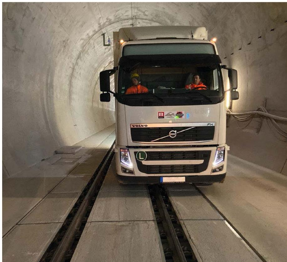
**Abb. 1:** Die Befahrbarkeitsplatten tragen Rettungsfahrzeuge mit 16 t Gesamtgewicht und 10 t Achs- beziehungsweise 5 t Radlast.
