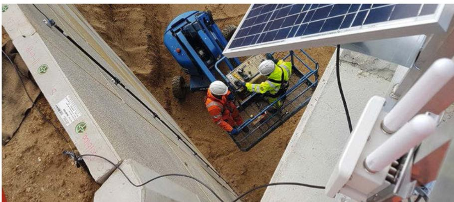
**Abb. 6:** Vertikal montierte Inklinometerkette aus Carbonfasersegmenten erlaubt die Beobachtung horizontalen Ausweichens aus der Senkrechten
