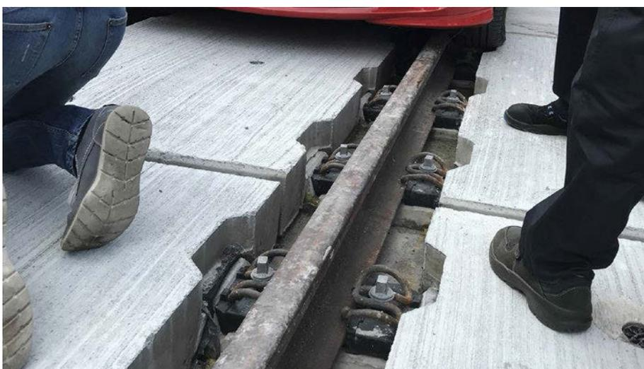
**Abb. 4:** Das „Sägezahnprofil“ der Befahrbarkeitsplatten wurde im Laufe des Projektes weiterentwickelt. Jetzt gewährleistet eine Verjüngung des Spaltes sowohl Befahrbarkeit als auch Inspizierbarkeit.
