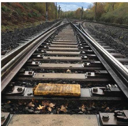
Abb. 1: Weichenkonstruktion, bewegliches Herzstück, Weichenantrieb (von links nach rechts)
