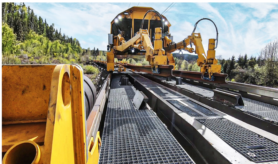
Abb. 4: Die Rutschenwagengarnitur ROREX ermöglicht gemeinsam mit dem Schienenmanipulator eine effiziente Schienenlogistik auf der Baustelle.
