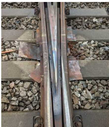
Abb. 4: Weichenherzstück nach Schleifarbeiten
