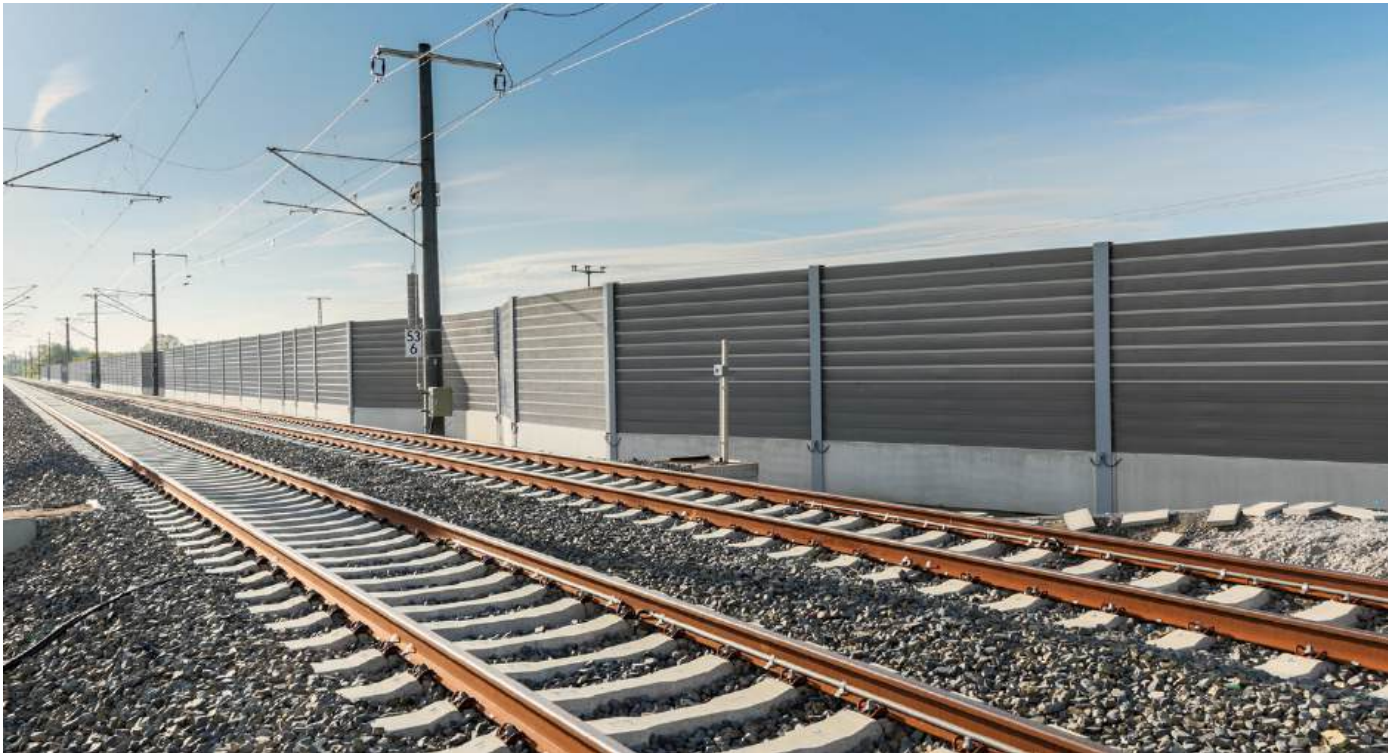
Abb. 1: Lärmschutzwand entlang von Bahnstrecke
