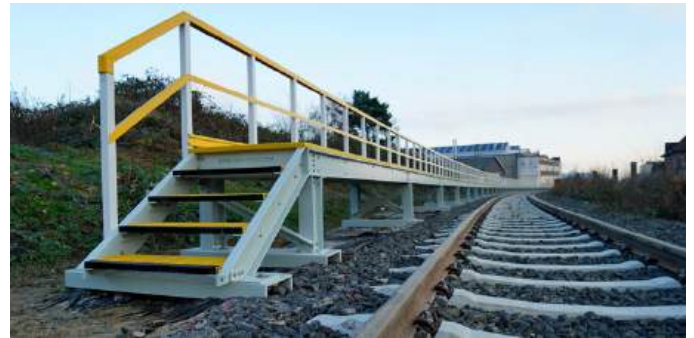
Arbeitspodest von CTS in Butzbach
