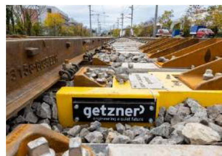
Sensor Sleepers helfen kritische Bereiche besser zu bewerten.
