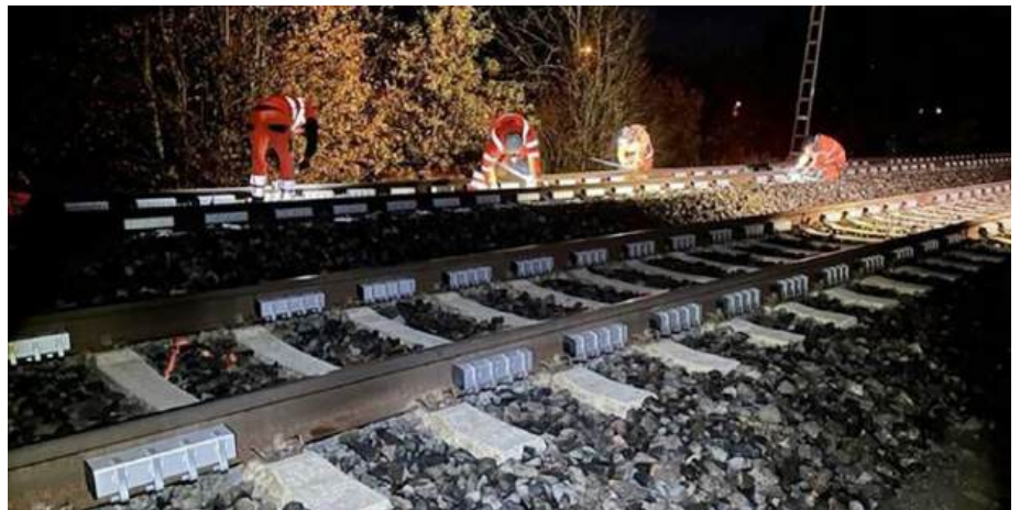
Abb. 4: Auch in kurzen Nachtsperrrpausen lässt sich das SSD-System sicher einbauen, wie hier bei der Baumaßnahme Trier-Ehrang. Quelle: M. J. Pregel / infra-tec GmbH
