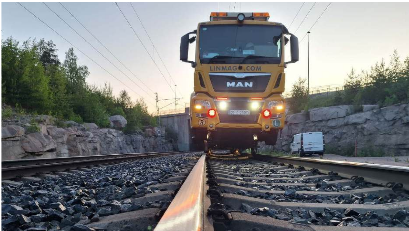
Abb. 1: Schienenfräsmaschine „SF02W-FS Truck“ bei Fräsarbeiten in Helsinki, Finnland (mit neu profilierter Schiene im Vordergrund)
