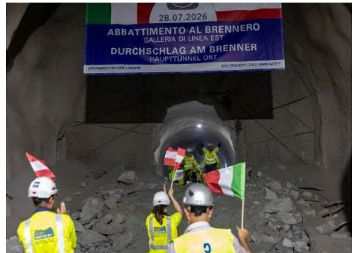
Durchschlag in einer der Haupttröhren
