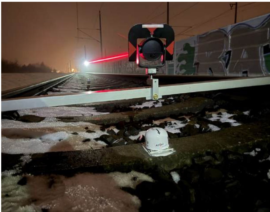
Abb. 4: Installierter Neigungssensor mit darüber aufgelegter Gleismesslatte. Der Laserpointer des Tachymeters ist sichtbar, während das Prisma eingemessen wird.
