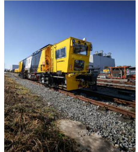
Hochwertige Schienenbearbeitung erhöht die Verfügbarkeit der Infrastruktur. Quelle: Robel
