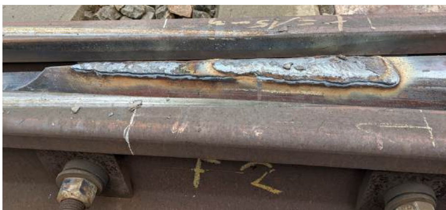
Abb. 3: Auftragsschweißung am Weichenherzstück
