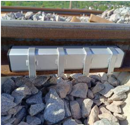
Abb. 2: Die Montage mit Klammern gewährleistet eine sichere Verbindung mit der Schiene. Quelle: A. Mustafa / infra-tec GmbH
