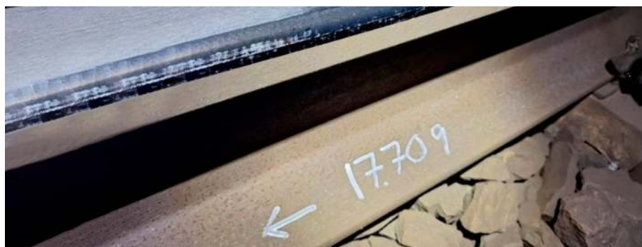
Abb. 9: Zustand nach drei Fräsdurchgängen und einer Gesamtabtragung von 3 mm – fehlerfreie und neu profilierte Schienen
