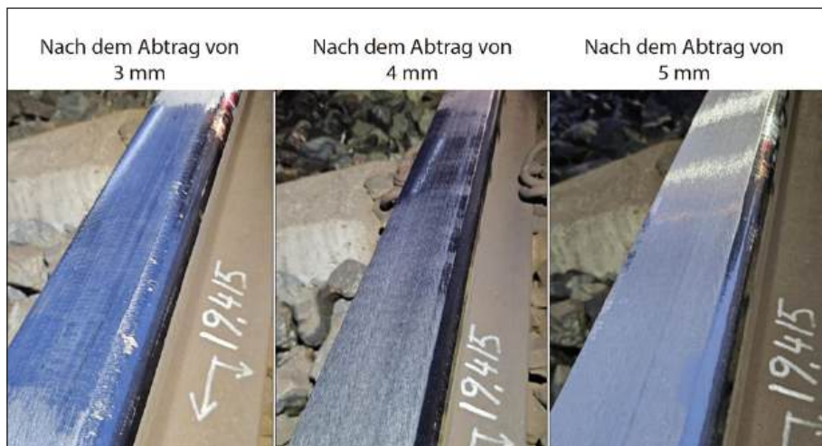
Abb. 6: Zustand nach dem 3., 4. und 5. Fräsdurchgang mit am Ende einer fehlerfreien und hochwertigen neu profilierten Schiene
