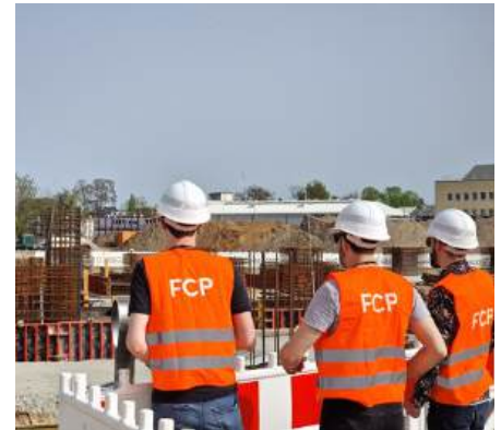
Das Neue Werk Cottbus wurde als Allianzmodell umgesetzt. Quelle: FCP
