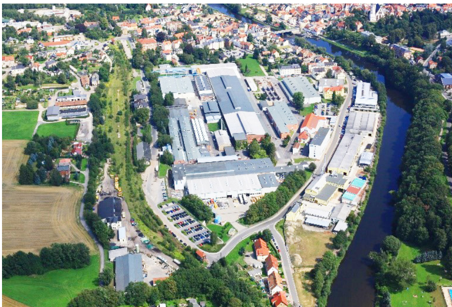
1: Der Standort der Siemens Traction Gears GmbH an der Thierbacher Straße in Penig, Sachsen
