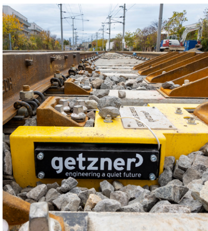
Sensor Sleepers helfen kritische Bereiche besser zu bewerten Quelle: Getzner Werkstoffe
