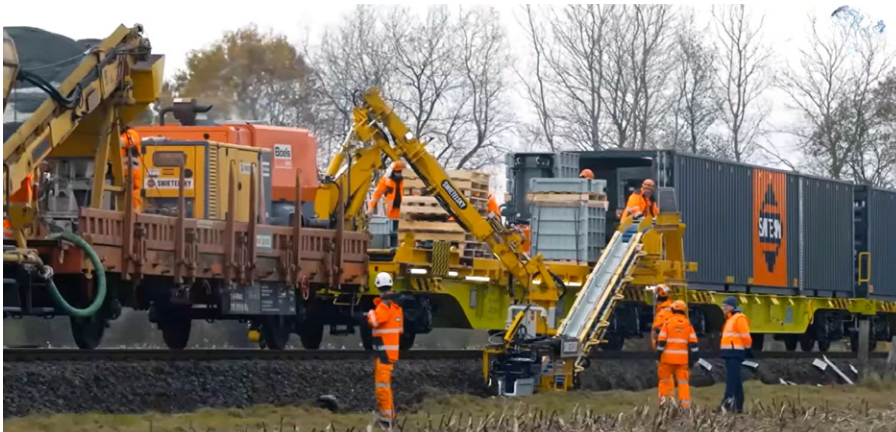
Kabeltiefbau mit Flankenprofilierungsmaschine
