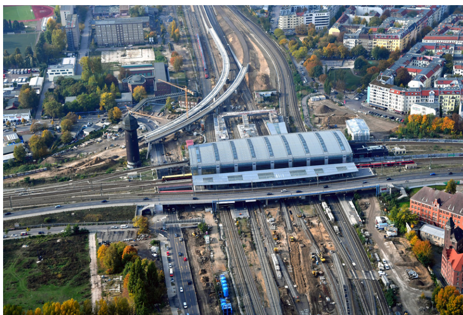
1: Baustelle Nahverkehrsknoten Berlin Ostkreuz
