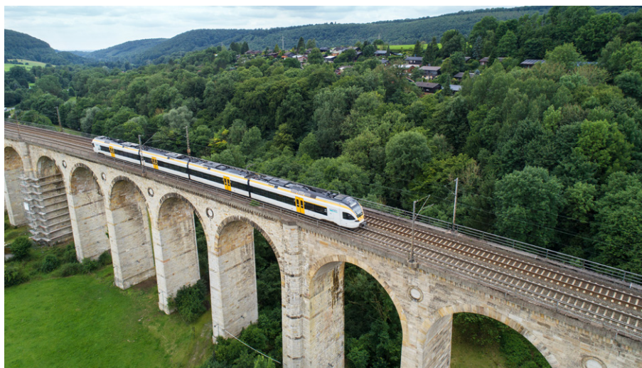
1: Stadler-Flirt-Triebzüge der eurobahn im Fahrgastbetrieb – die Flotte diente als Einsatzplattform für den mehrjährigen Feldtest zur Verlängerung der Ölwechselintervalle Quelle: Alpha Trains
