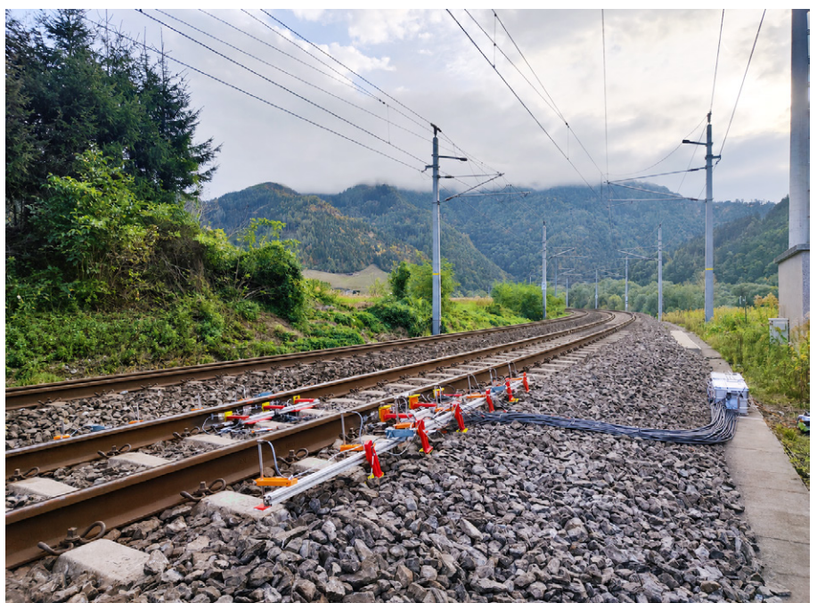
3: Gleismessung im Betriebsgleis: Reale Fahrwegdaten ergänzen Laborversuche und numerische Simulationen und bilden eine Grundlage für die Validierung experimenteller Untersuchungen Quelle: TU Graz/RID
