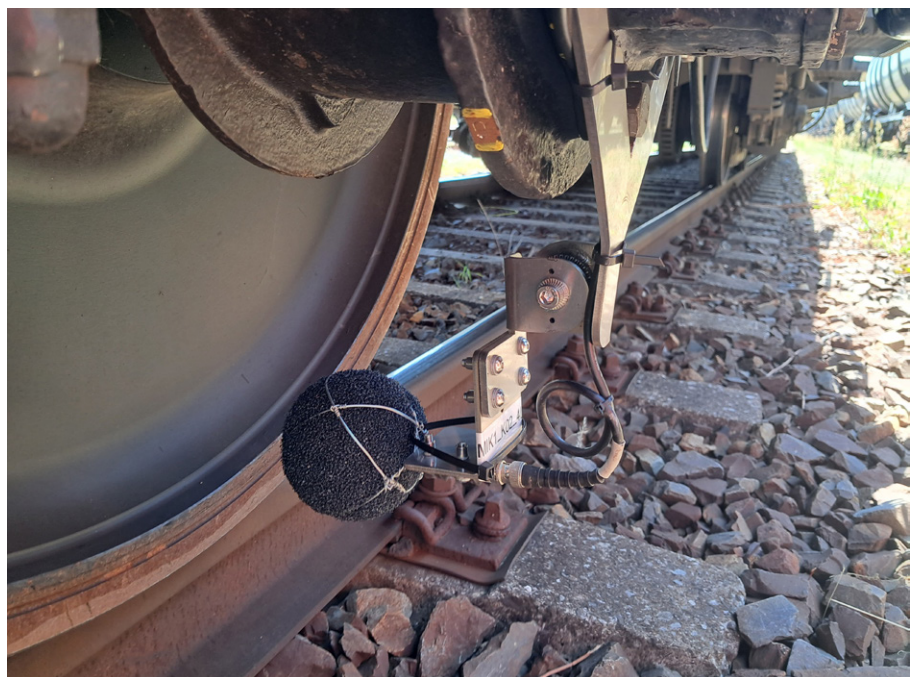
3: Installation von Messmikrofonen
