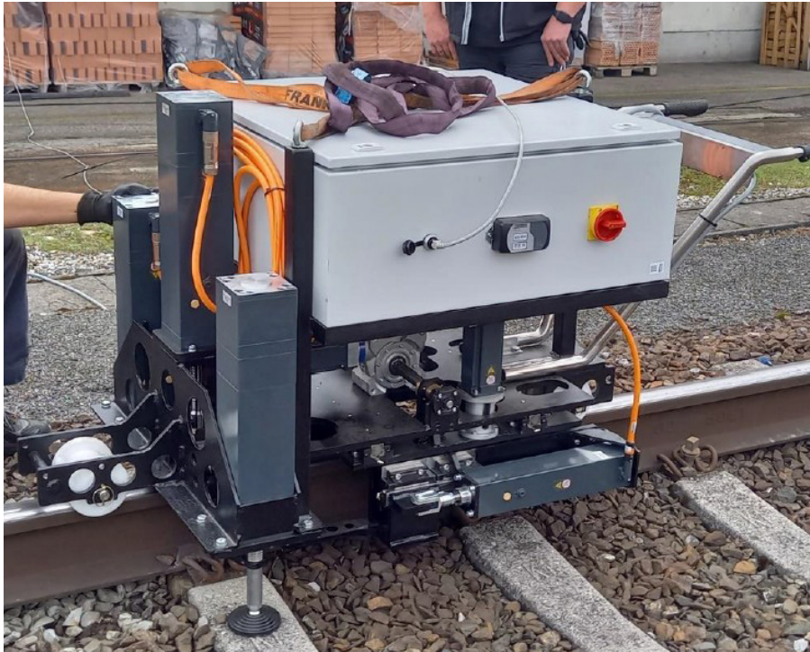
2: Halbautomatisiertes Arbeitsverfahren mit dem Zwischenlagewechsler
