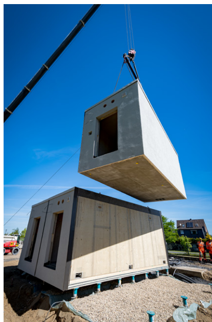
Die Technikeinhausung als Holzbau-Lösung Quelle: Ulrich Schepp – Die Profifotografen
