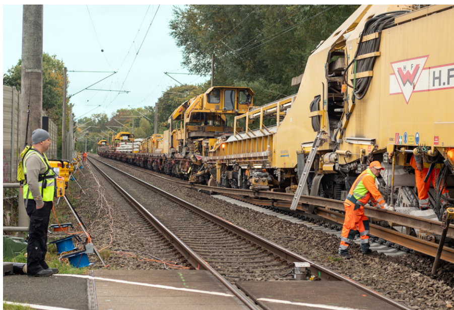
4: Das maschineneigene Warnsystem wird mit einem feldseitig aufgebauten kabelgebundenen Warnsystem kombiniert, um maximale Sicherheit für Arbeitende auf Großbaustellen zu gewährleisten
