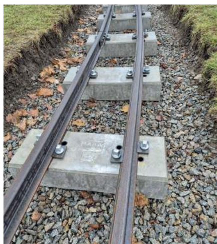
2: 80 Zentimeter lang, 16 Zentimeter hoch: Die speziell entwickelte MABA Betonschwelle musste exakt auf das historische Gleissystem der Liliputbahn abgestimmt werden
