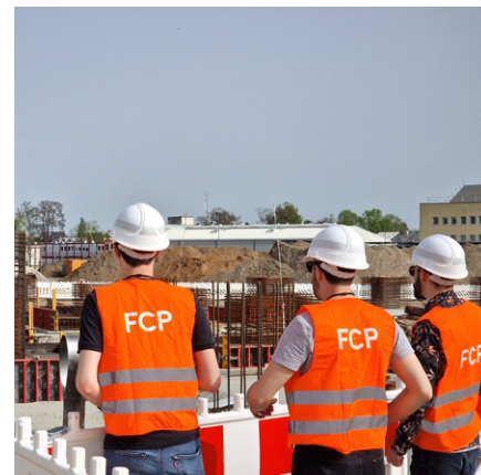
Das Neue Werk Cottbus wurde als Allianzmodell umgesetzt Quelle: FCP
