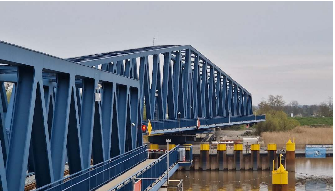
Bild 1: Der Neubau der Friesenbrücke als Hub-Dreh-Brücke
