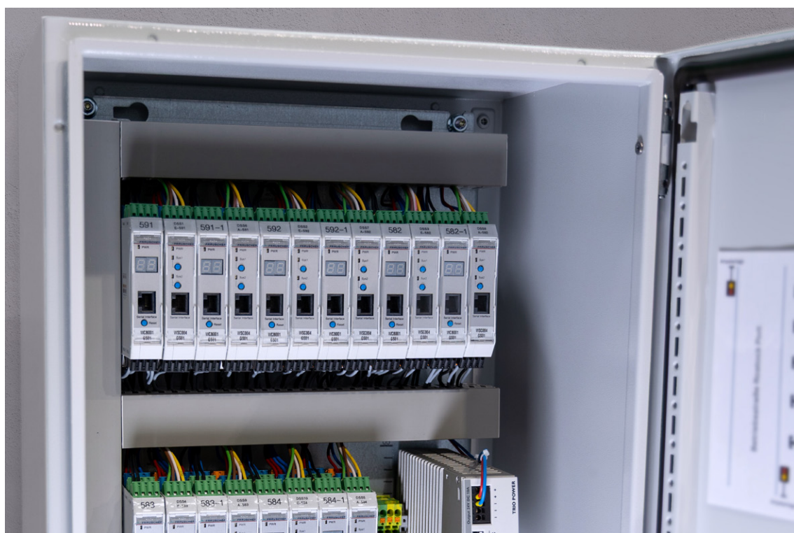
Bild 6: Das FTVS wird platzsparend auf einer Hutschiene montiert.
