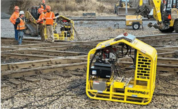
Abb. 7: Kürzere Sperrzeiten bei Gleisbauarbeiten soll das Gleishebeselement TL 248 von Enerpac ermöglichen. Foto: Enerpac
