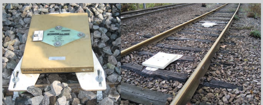
Bild 4: Standard-Balise der Firma Ansaldo; Montage auf Zweiblock- und Holzschwellen für die Transition, Übergang POS
