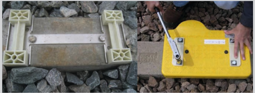
Bild 10: Montage kleine Balise von Alstom auf Betonschwelle mit H-Halter
