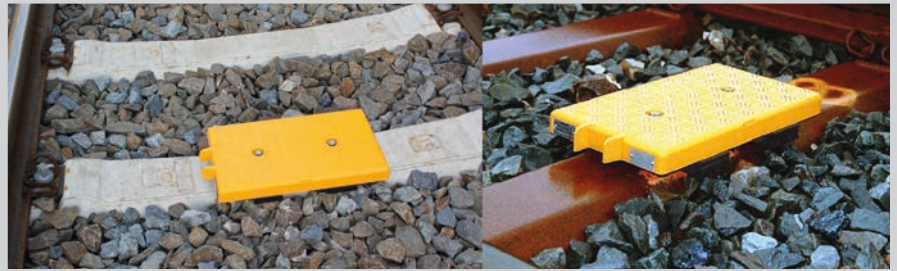
Bild 2: Montage Balise S 21 auf Betonschwelle sowie auf Stahlschwelle
