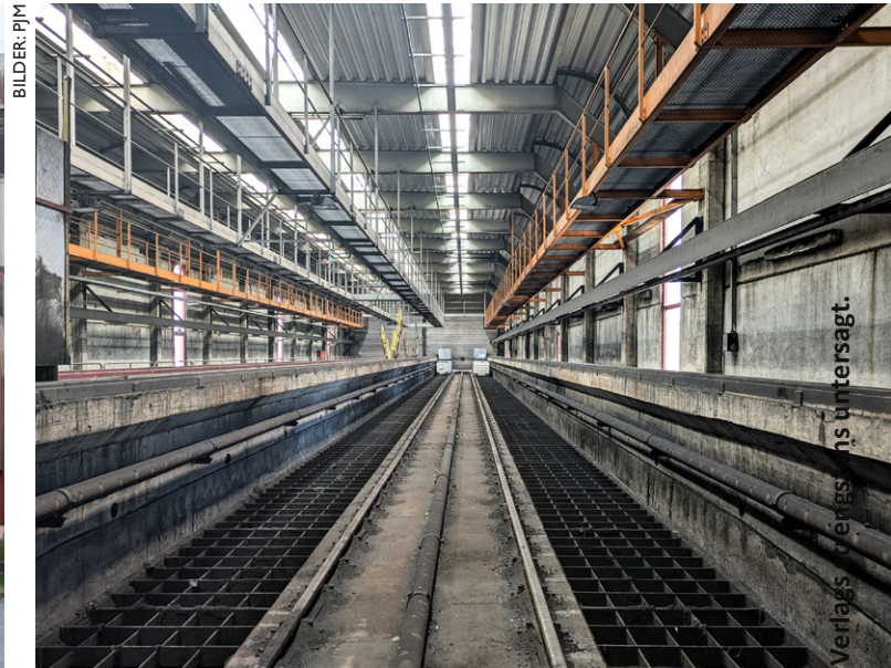
Die zweigleisige Halle in Mellach ist mit einem Dacharbeitsstand sowie einem Kran ausgestattet.
