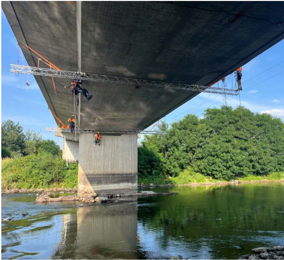
Abb. 9: Einsatz von Industriekletterern zur Sensorinstallation
