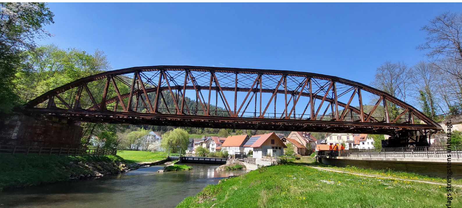
Abb. 1: Die Eisenbahnüberführung Unterreichenbach stammt aus dem Jahr 1876 und musste im Rahmen einer ganzheitlichen Bauwerksanalyse und -überwachung umfangreichen Materialuntersuchungen unterzogen werden.
