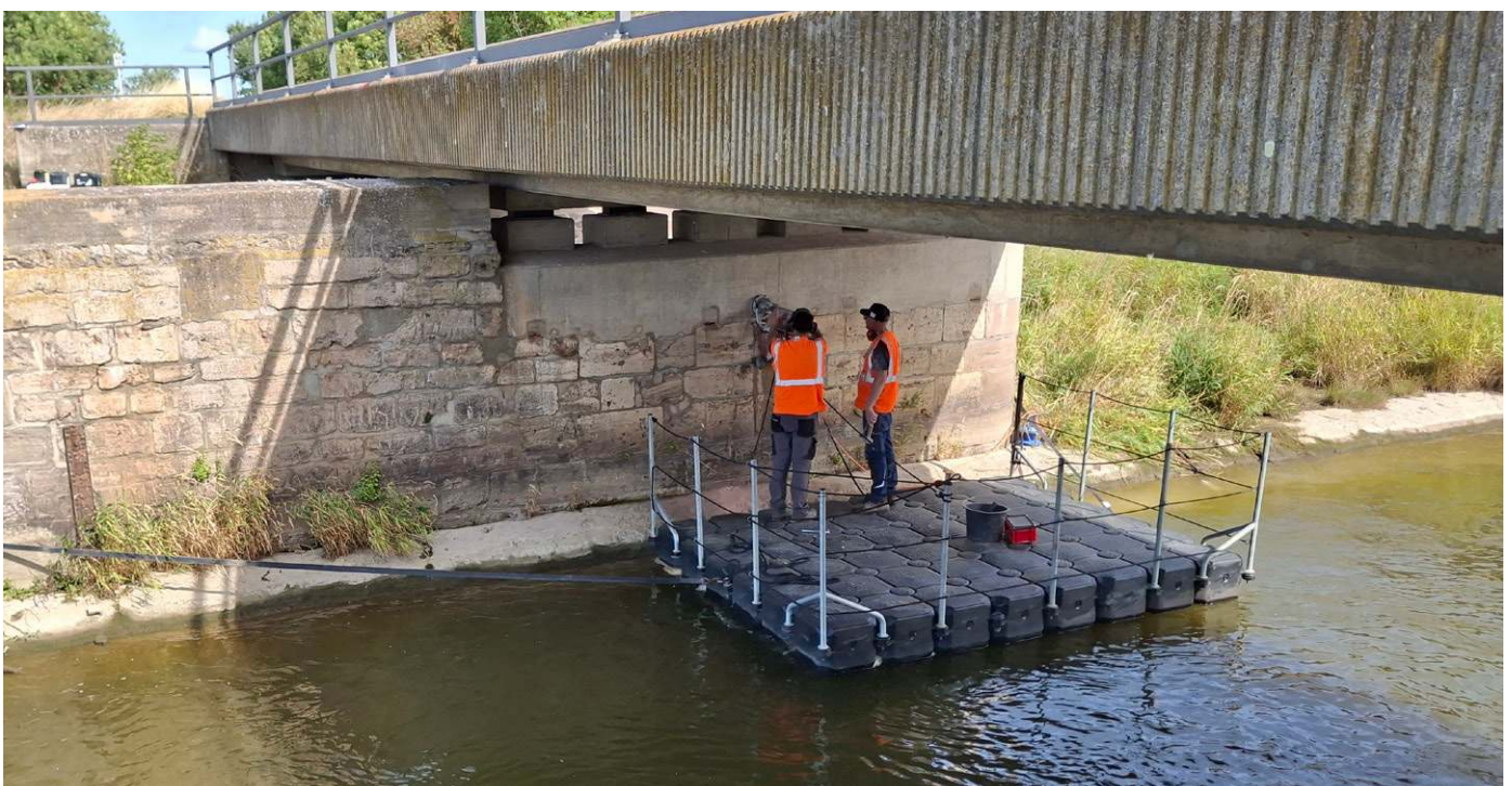
Abb. 4: Bauwerksdiagnostische Untersuchungen unter Zuhilfenahme eines Ponton
