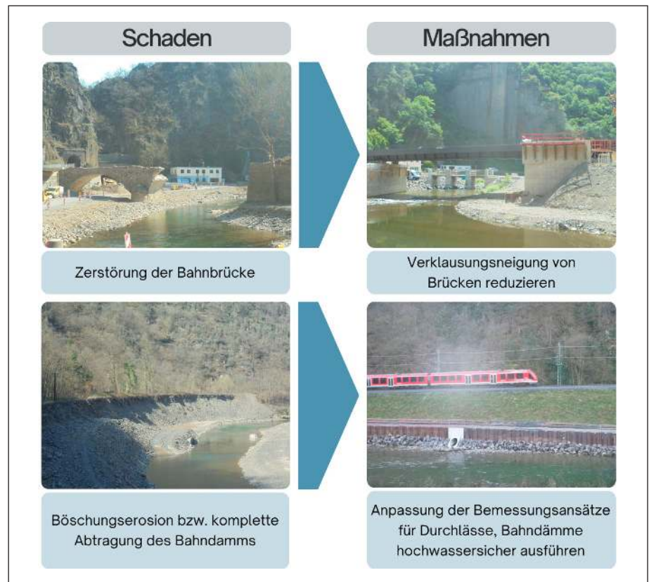
Abb. 3: Beispiele für hochwasserinduzierte Schäden im Zuge des Extremereignisses im Juli 2021 und umgesetzte ingenieurtechnische Maßnahmen entlang der Ahrtalstrecke Quelle: DZSF
