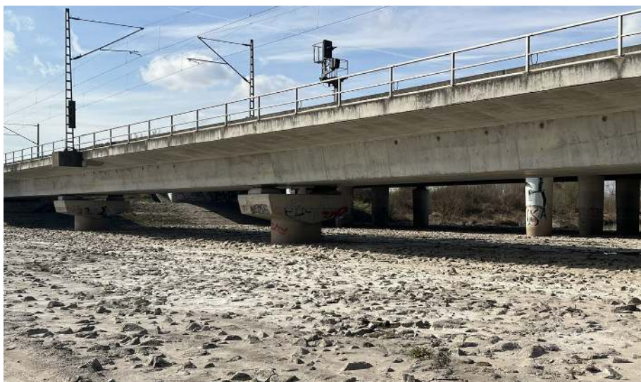
Abb. 8: Magerbetonboden mit eingebetteten Steinen an der Elbeflutbrücke II
