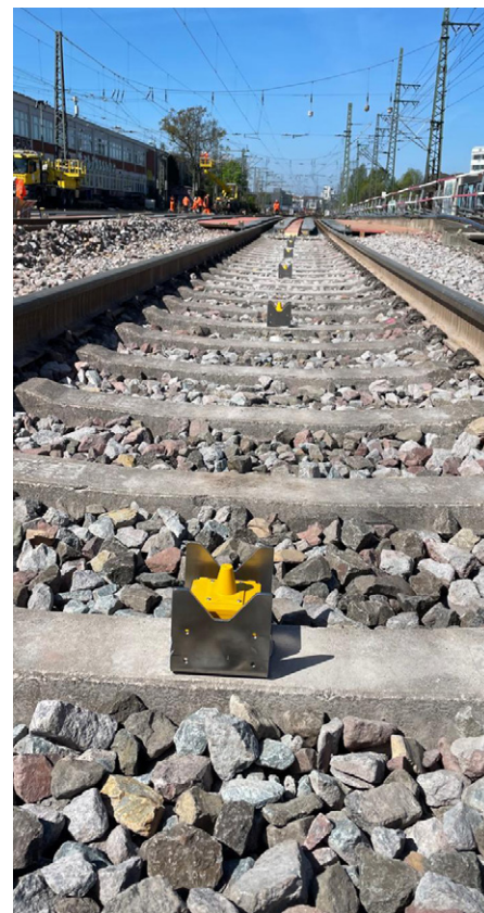
Abb. 2: Eingebaute Sensoren im Einsatz zur Überwachung einer Hilfsbrücke Quelle: C. Gregersen
