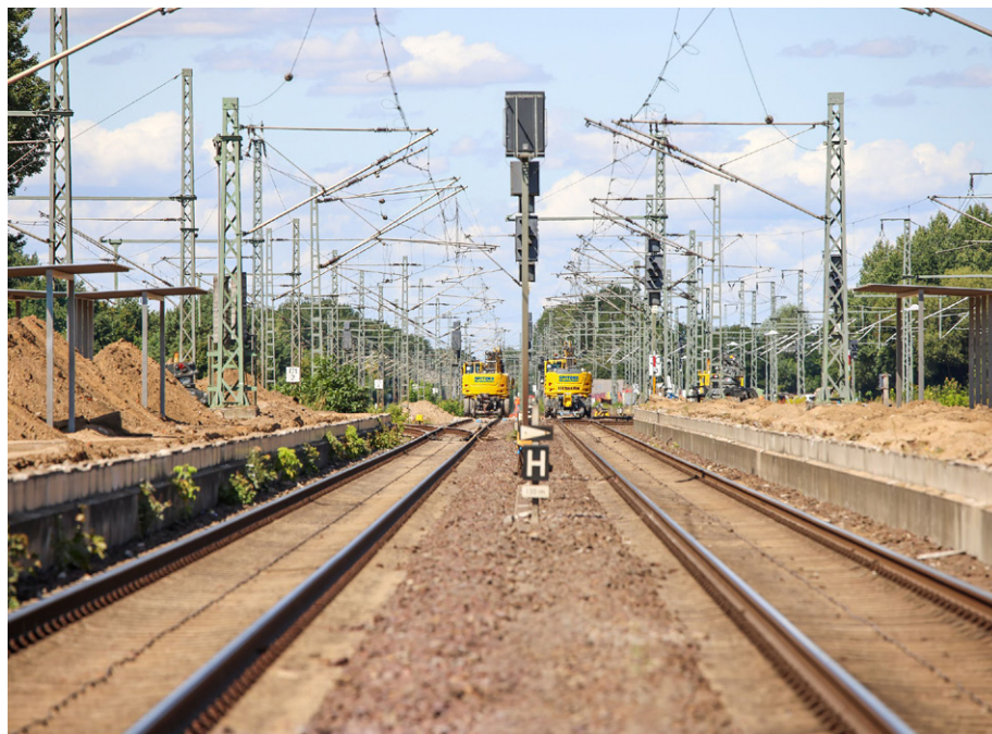
Abb. 1: Korridorsanierung Hamburg – Berlin: Insbesondere im Bereich von Verkehrsstationen bedingen zahlreiche Bauwerke einen hohen Bedarf an Vermessungsdaten.
