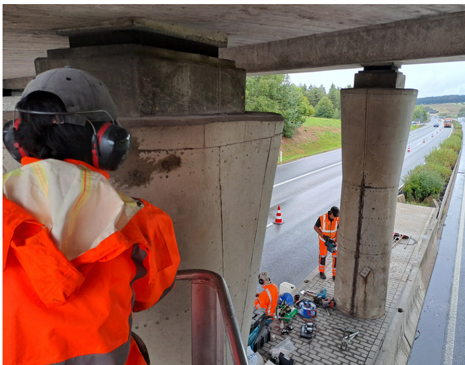
Abb. 5: Bausubstanzuntersuchungen am Pfeiler einer Brücke der Autobahn GmbH
