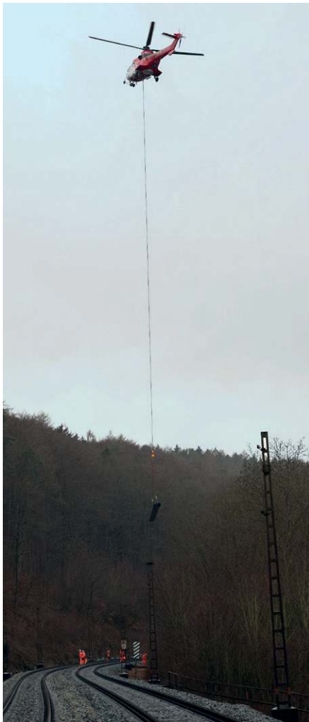
Abb. 4: Auf dem Korridor Nürnberg – Regensburg waren die Standorte der Oberleitungsmaste derart unzugänglich, dass in vielen Bereichen Gründungsrohre, Maste und Kofferrundamente eingeflogen wurden.
