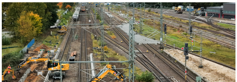
Generalsanierung Hamburg – Berlin, hier: Arbeiten im Bereich des Bahnhofes Ludwigslust
