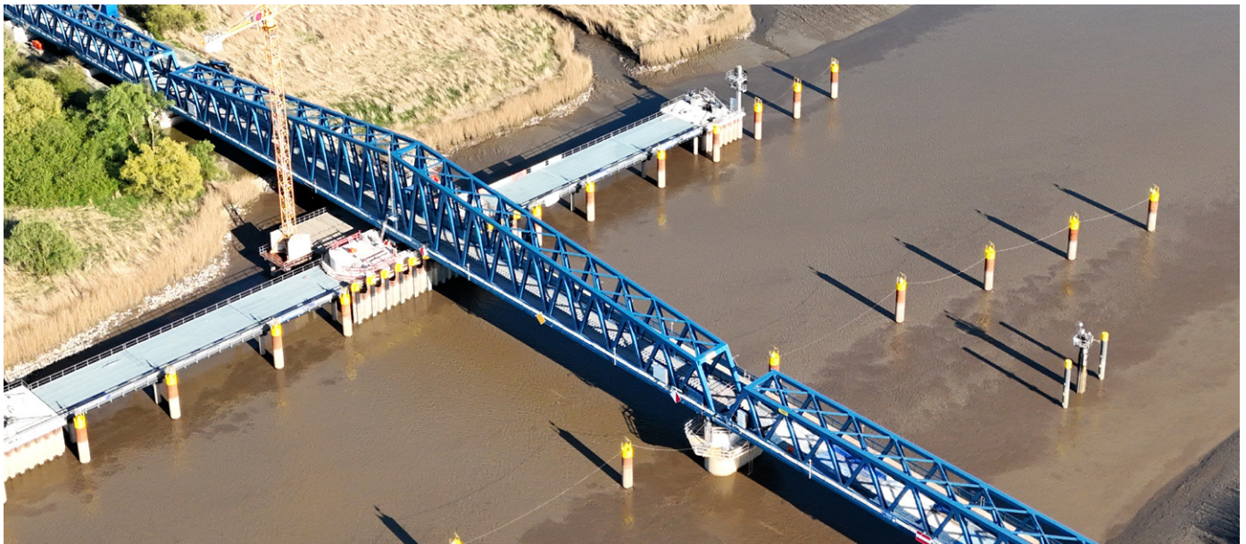
Abb. 1: Friesenbrücke über die Ems bei Weener
