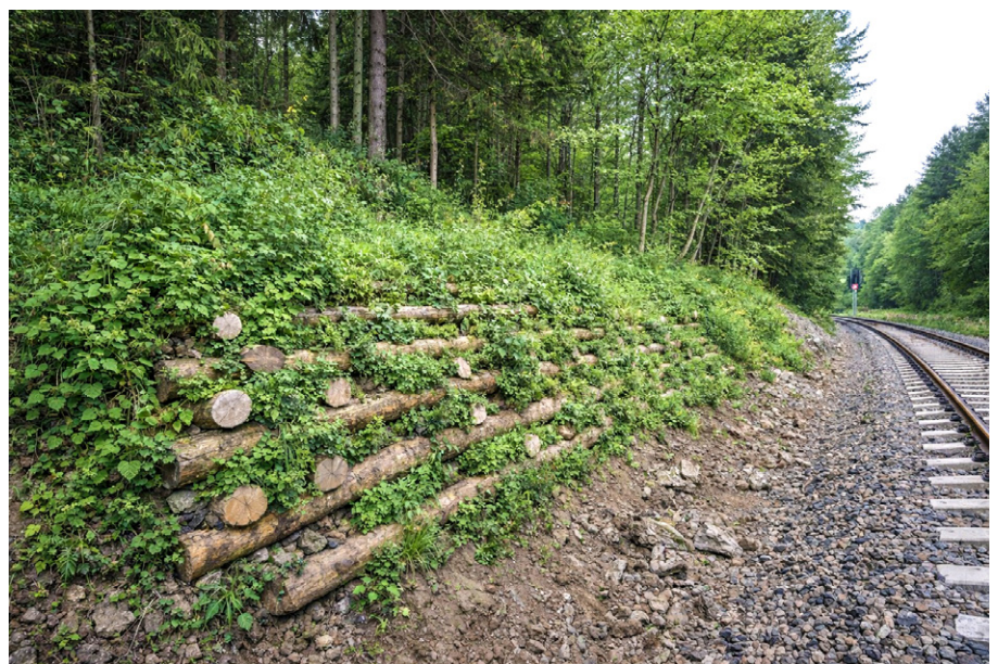
5: Begrünte Holzstützwand nach Etablierung der Vegetation
