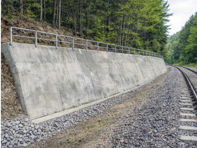
3: Konventionelle Böschungssicherung (graue Infrastruktur) Quelle: KI-generiert
