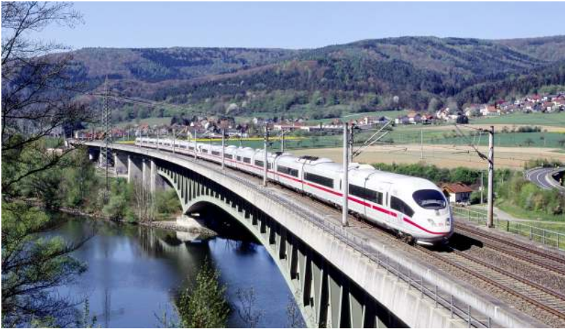
17: ICE 3 auf der Mainbrücke Nantenbach
