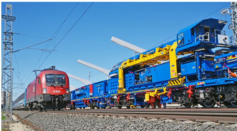
1: Materialtransporte im Baugleis ermöglichen den Betrieb am Nebengleis
